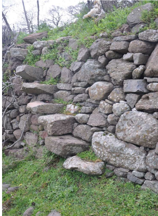
Trockenmauer mit „Treppe“
