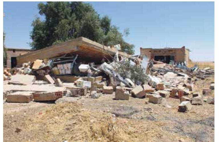
Das zerstörte Grabungshaus in Tell-Chuera (2015).
